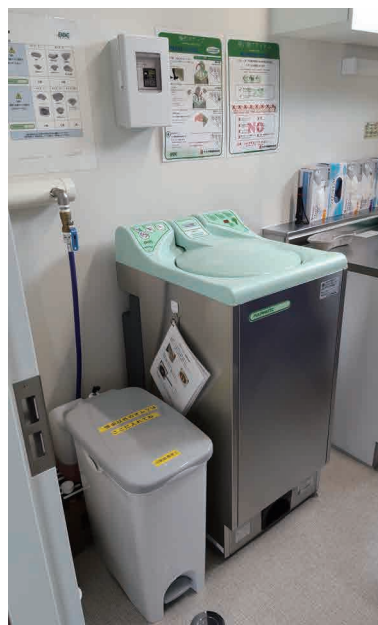
マセレーター設置の様子
